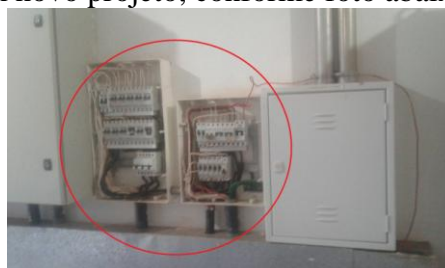
Figura 6 – Quadros a serem substituídos pelo QDLT-ES)
