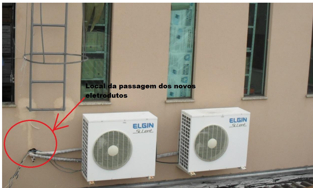
Figura 3 – Entrada dos eletrodutos para a cobertura do prédio
