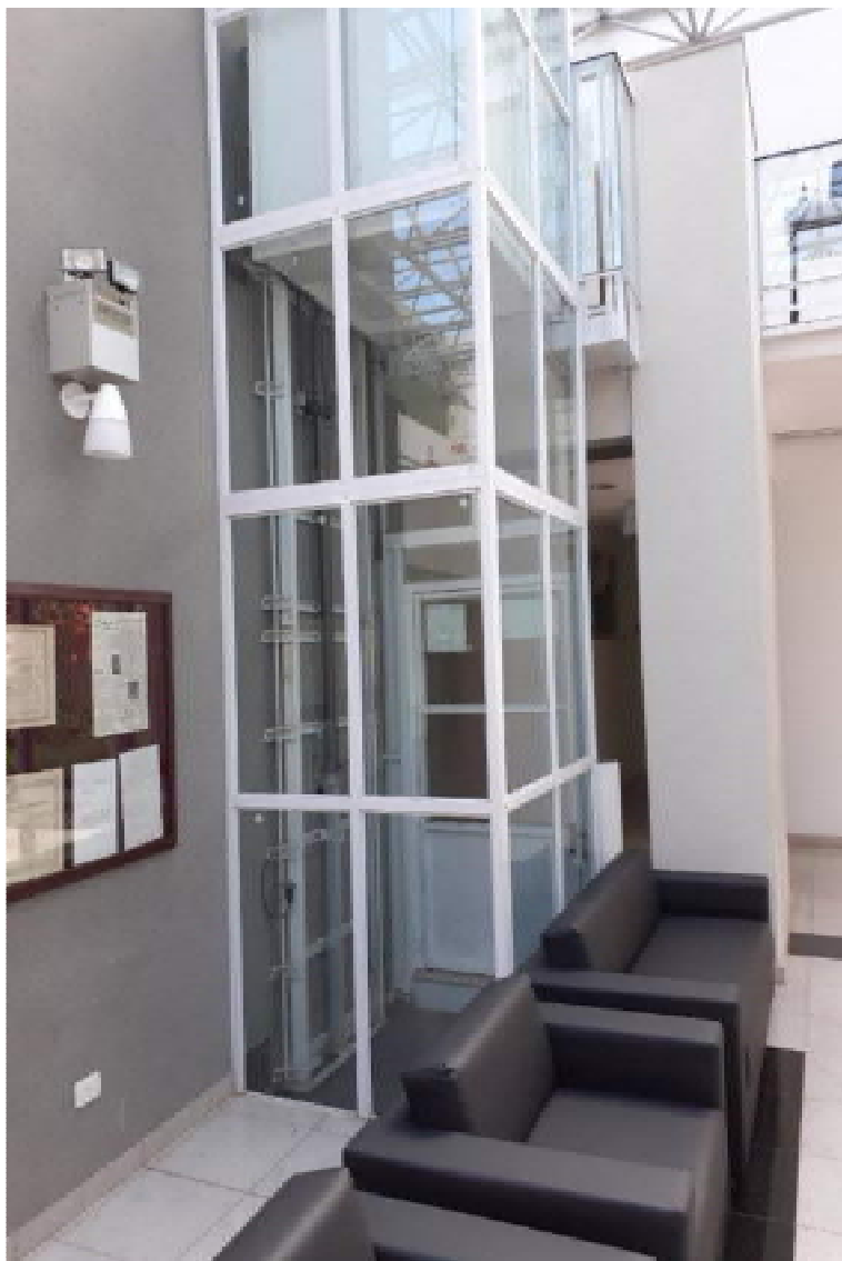
Foto 47: parte da estrutura de enclausuramento da plataforma elevatória instalada no saguão interno do prédio principal (área envidraçada e estrutura metálica).
