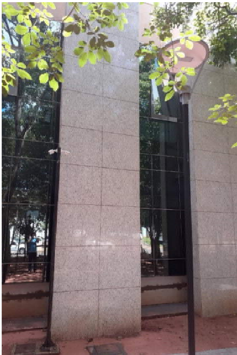
Foto 13: detalhe da fachada lateral do prédio sede do TRE/MS, com destaque para as placas de granito que revestem as colunas que se destacam da fachada e detrás destas a área envidraçada (pele de vidro).
