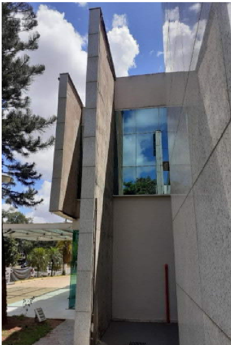
Foto 6: parte do lado direito da fachada frontal do prédio sede do TRE/MS, com destaque para as placas de granito que revestem coluna que se destaca da fachada; para área envidraçada (pele de vidro) posicionada detrás da parte central da fachada (acesso principal); e para a superfície de concreto da coluna de sustentação do granito (face de trás da coluna).
