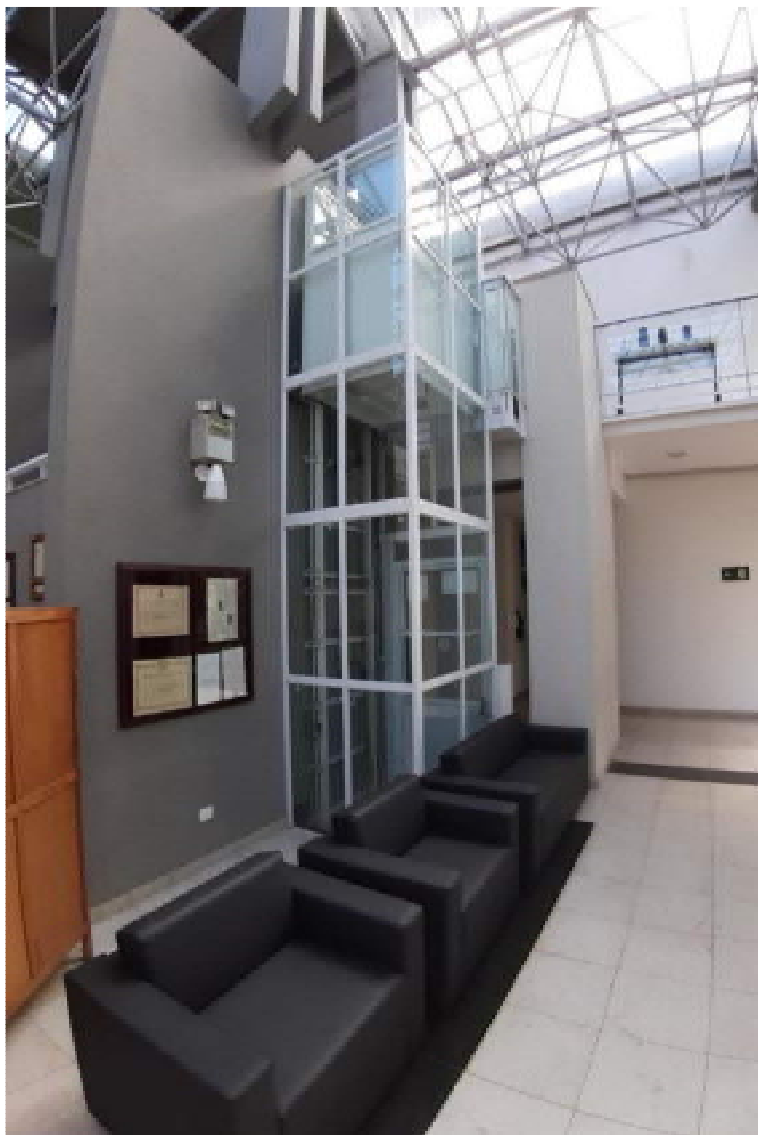
Foto 48: estrutura de enclausuramento da plataforma elevatória instalada no saguão interno do prédio principal (área envidraçada e estrutura metálica).
