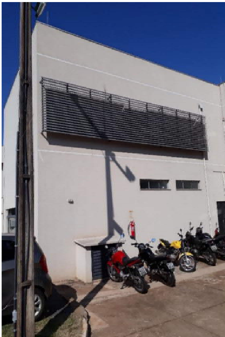
Foto 34: parede do prédio do Anexo do NSI/COENG, voltada para o acesso à cabina de força, em que se veem o brise e as janelas existentes (as esquadrias que serão objeto da limpeza são as posicionadas detrás do brise).
