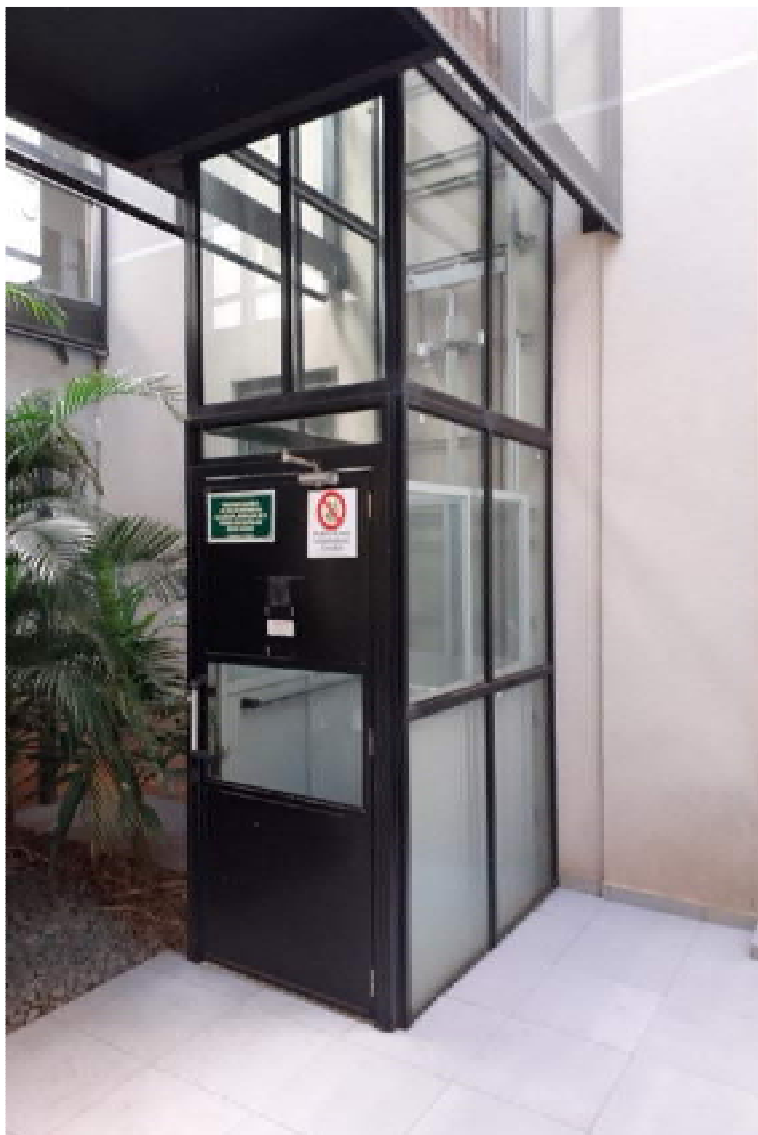
Foto 43: parte inferior da estrutura de enclausuramento da plataforma elevatória, área envidraçada e estrutura metálica.
