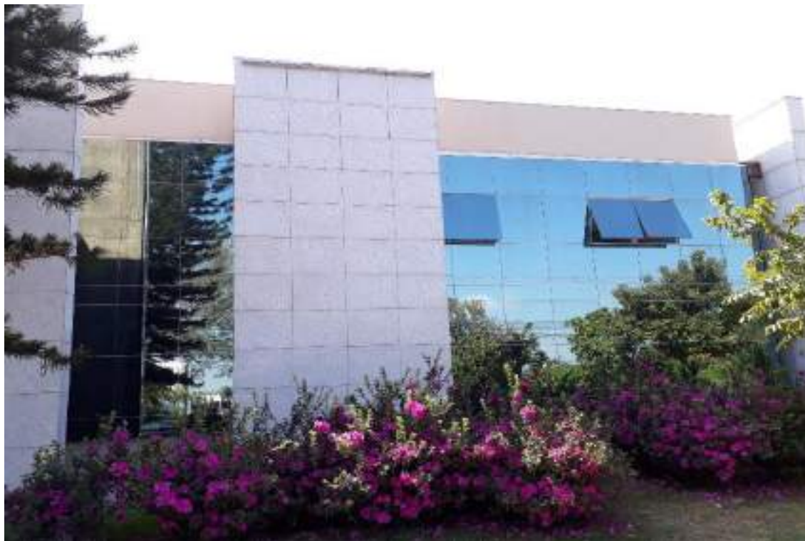
Foto 7: parte do lado direito da fachada frontal do prédio sede do TRE/MS, com destaque para a área envidraçada (pele de vidro) e as placas de granito que revestem coluna que se destaca da fachada.
