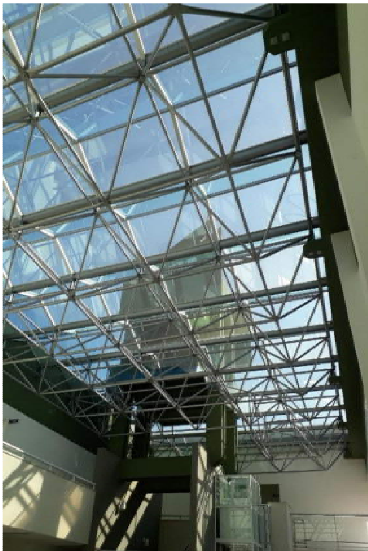
Foto 46: cobertura do saguão interno do prédio principal, com destaque em primeiro plano para a estrutura metálica dessa cobertura, e em segundo plano a face inferior da área envidraçada.
