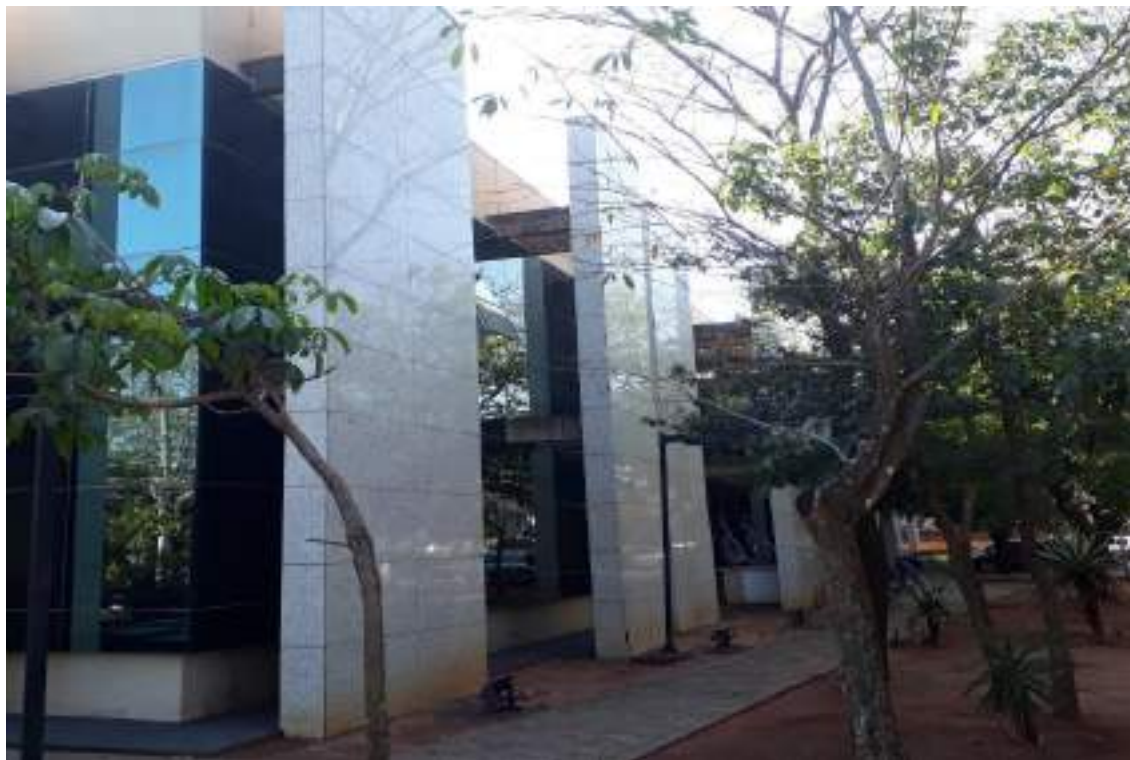
Foto 12: parte da fachada lateral do prédio sede do TRE/MS, com destaque a área envidraçada (pele de vidro) e as placas de granito que revestem as colunas que se destacam da fachada.
