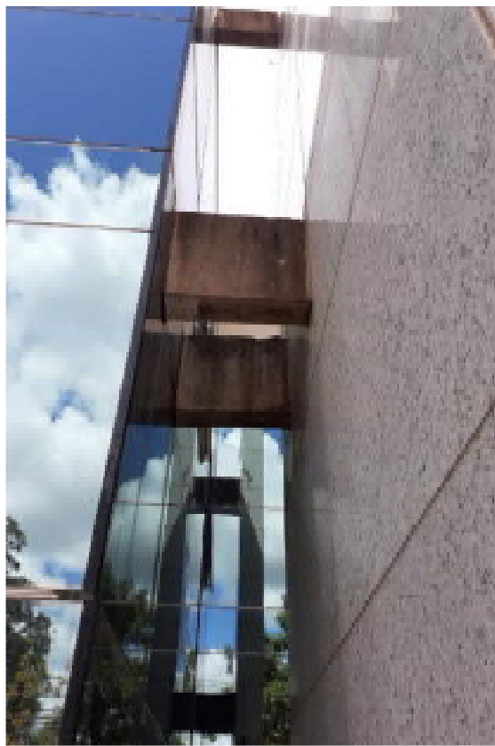
Foto 9: parte de trás das colunas que se destacam da fachada, em que se vêem as vigas de concreto que conectam as colunas ao prédio principal.
