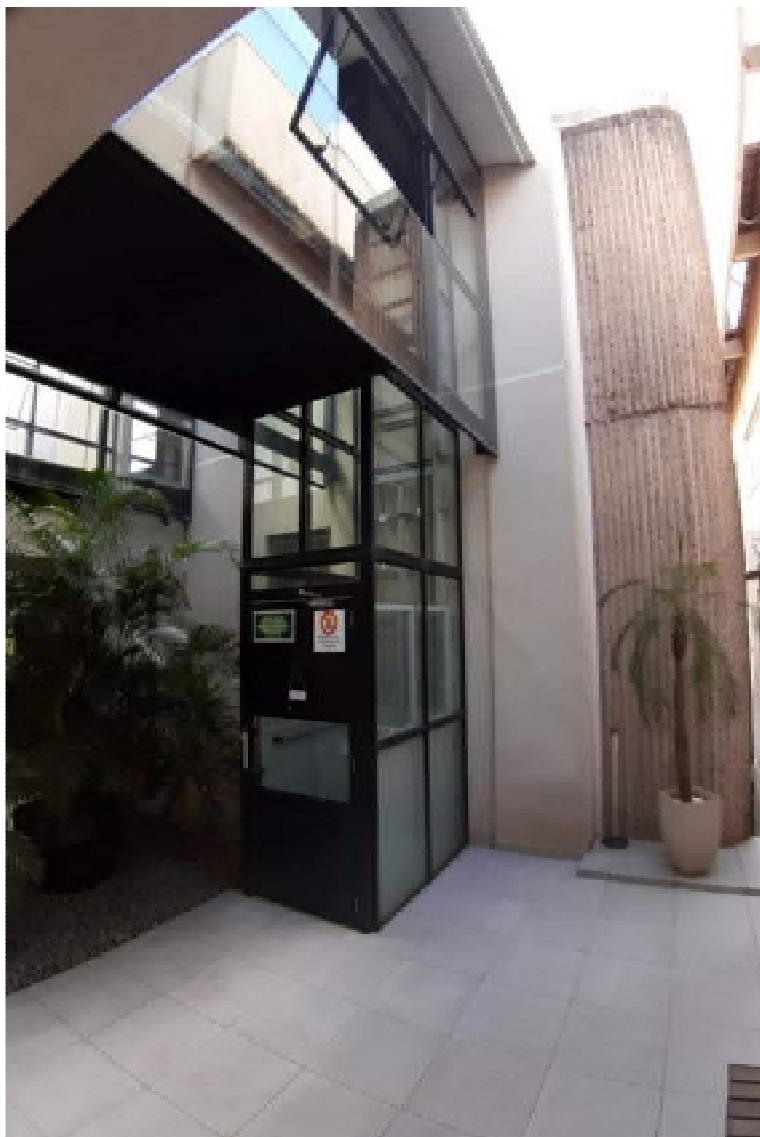
Foto 44: estrutura de enclausuramento da plataforma elevatória, área envidraçada e estrutura metálica.
