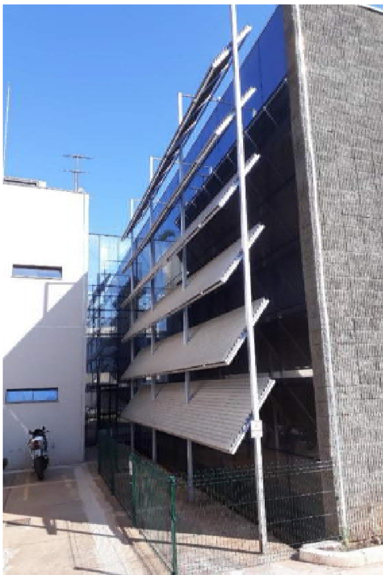
Foto 26: parte da lateral do prédio do Anexo da Presidência, voltada para o acesso à cabina de força, com destaque para o brise sobreposto à área envidraçada (pele de vidro).
