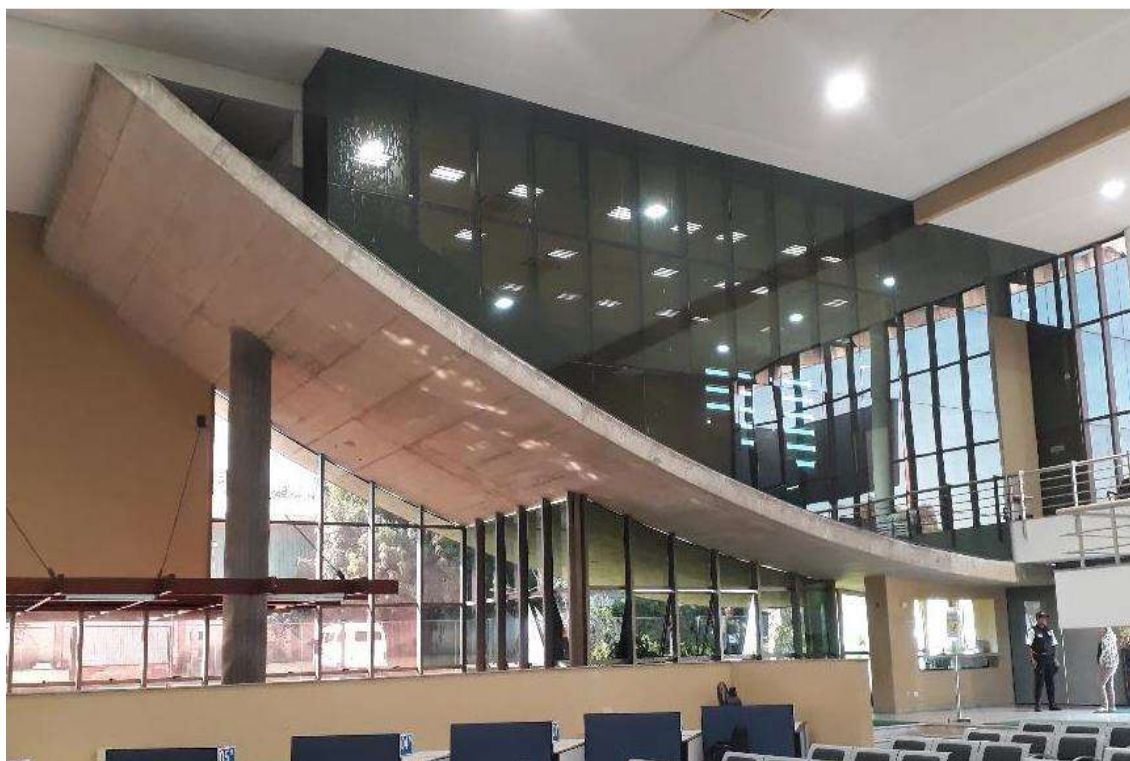
Foto 55: área interior dos auditórios do prédio do Fórum Eleitoral de Campo Grande, com destaque para a estrutura de sustentação em concreto e a área envidraçada (pele de vidro), na lateral do auditório – vista lateral, a partir a Central de Atendimento ao Eleitor.
