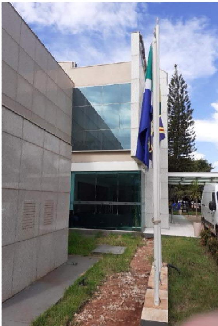
Foto 3: parte do lado esquerdo da fachada frontal do prédio sede do TRE/MS, com destaque para as placas de granito que compõem a fachada e para área envidraçada (pele de vidro) posicionada detrás da parte central da fachada (acesso principal).
