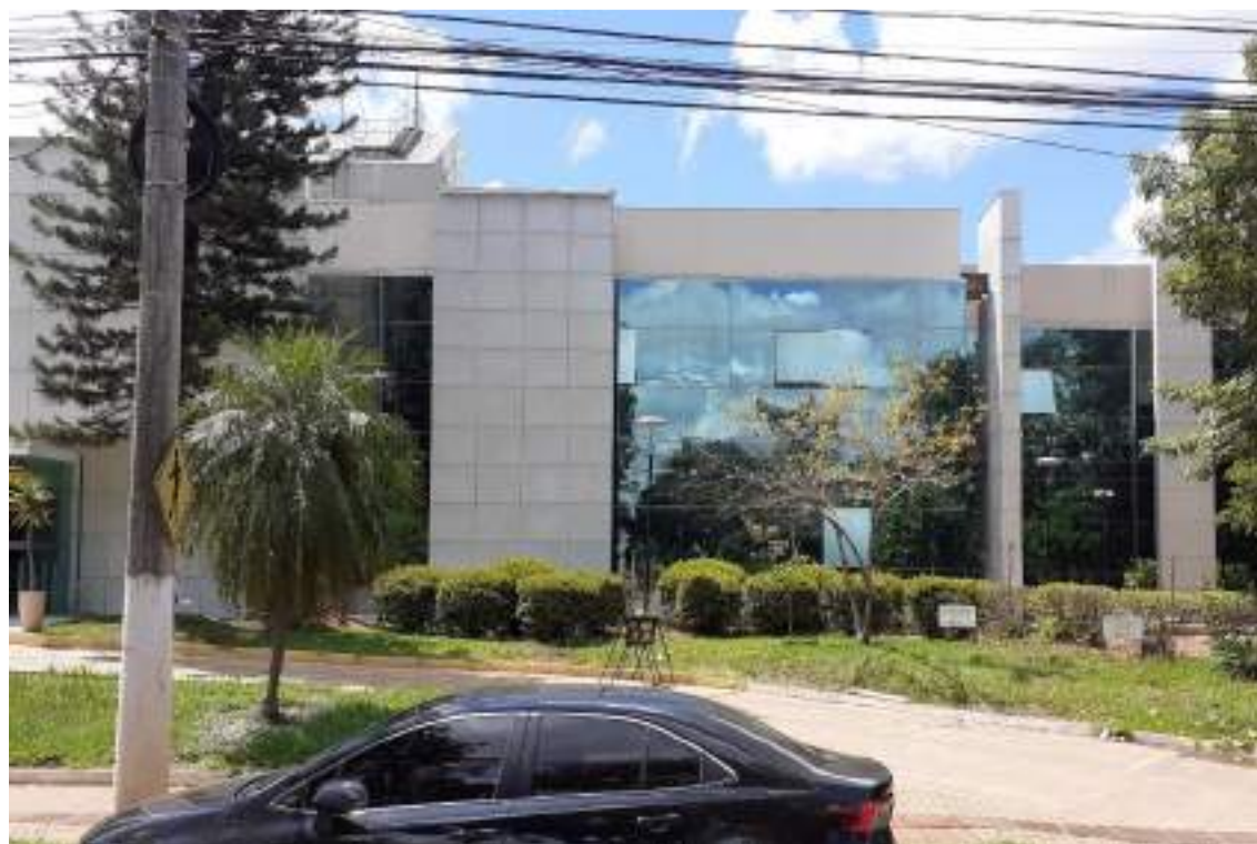
Foto 5: Lado direito (a partir da posição do observador) da fachada frontal do prédio sede do TRE/MS, com destaque para a área envidraçada (pele de vidro) e as placas de granito que revestem colunas que se destacam da fachada.
