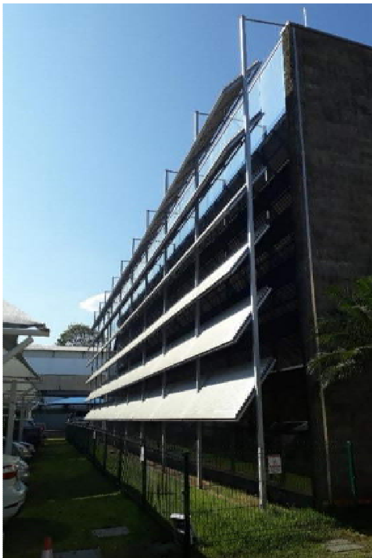
Foto 23: lateral do prédio do Anexo da Presidência, voltada para o estacionamento principal, com destaque para o brise sobreposto à área envidraçada (pele de vidro).
