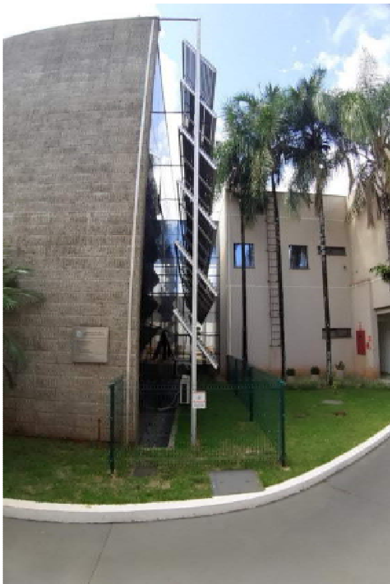
Foto 28: parte da lateral do prédio do Anexo da Presidência, voltada para o jardim interno, com destaque para o espaço existente entre o brise e a área envidraçada (pele de vidro).
