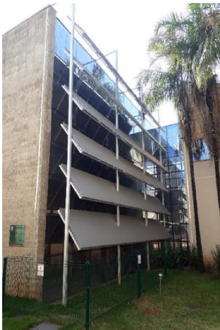
Foto 27: parte da lateral do prédio do Anexo da Presidência, voltada para o jardim interno, com destaque para o brise sobreposto à área envidraçada (pele de vidro).
