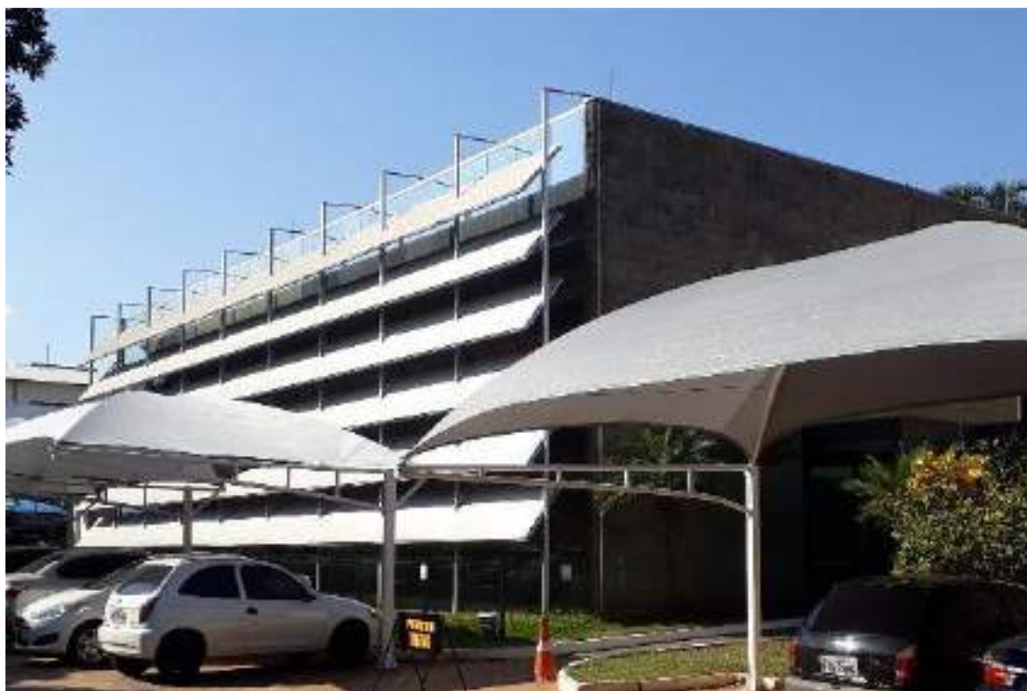
Foto 22: lateral do prédio do Anexo da Presidência, voltada para o estacionamento principal, com destaque para o brise sobreposto à área envidraçada (pele de vidro).
