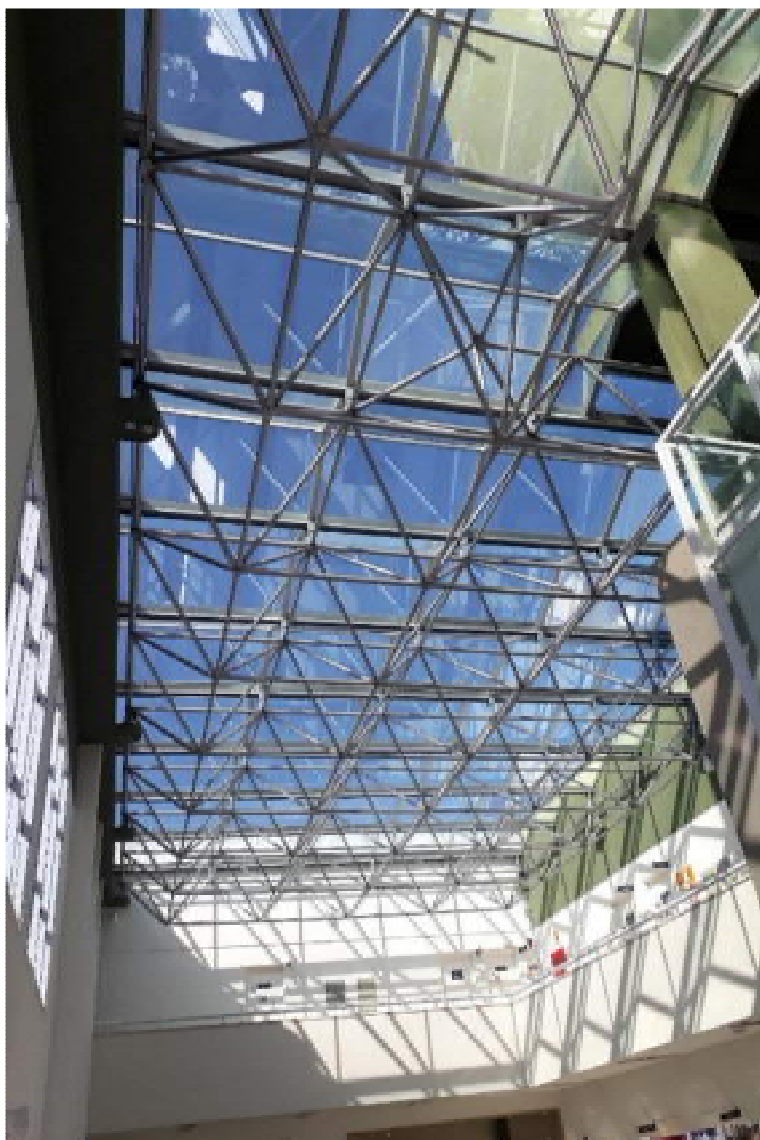
Foto 45: cobertura do saguão interno do prédio principal, com destaque em primeiro plano para a estrutura metálica dessa cobertura, e em segundo plano a face inferior da área envidraçada.
